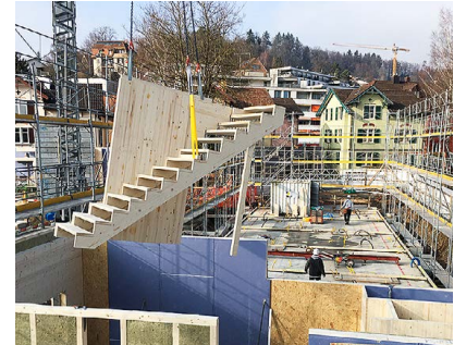
Das Aufrichtfest der Townhouses am Spitzweg wird mit der Bauherrschaft und den Handwerkenden traditionell als Dankeschön für die geleistete Arbeit gefeiert.
